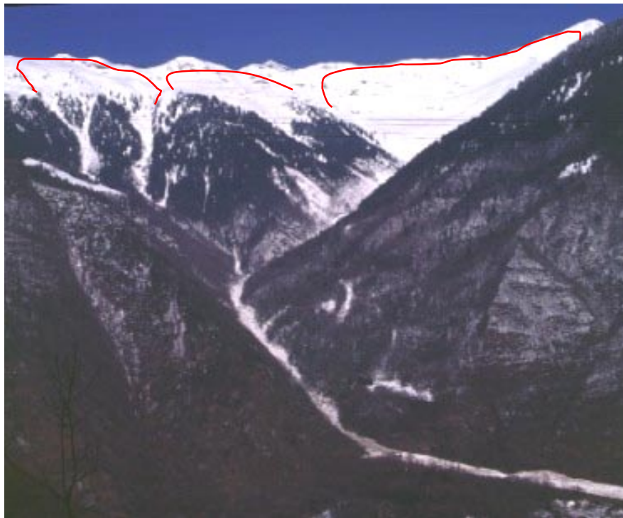
• Figure 41 : vue d'une partie des zones d'accumulation du bassin du Saint-Clément et aperçu du chenal d'écoulement après l'avalanche du 20 février 1999.
